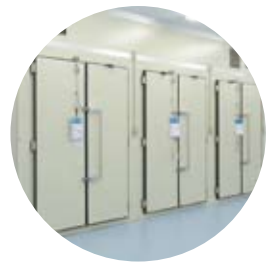
エアレーション室
